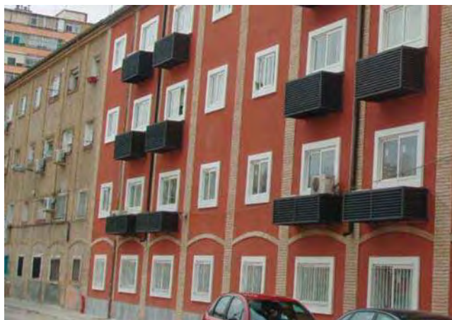
Figura 71. Rehabilitación de viviendas llevada a cabo en el barrio del Picarral en Zaragoza (Zaragoza Vivienda)
