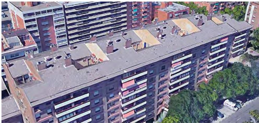
Figura 43. Ejemplo de cubierta inclinada con orientación Sur. Permite un mejor aprovechamiento de la superficie de la cubierta, si bien el acceso para mantenimiento es más difícil, siendo necesario adoptar medidas de seguridad en el trabajo. Este es el caso de edificios construidos antes de la aplicación del CTE. (Google earth)
