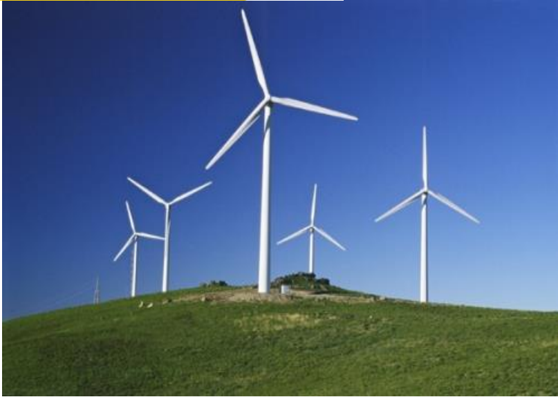
Parque eólico conectado a red en régimen ordinario ( sin prima) Cordal de Montouto, A Coruña, marzo 2015 Promotor : Gas Natural Unión Fenosa Potencia instalada 14 MW Producción estimada : 37 GWh/año
