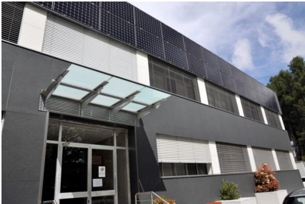
CIEMAT. Madrid, Avenida Complutense 40. División de Energías Renovables Integración de Energía Solar Fotovoltaica en edificios. Potencia instalada: 27,2 kWp
