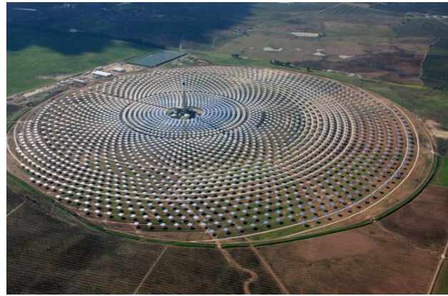
GEMASOLAR. Potencia: 20 MWe. Almacenamiento: 15h a potencia nominal En verano la planta puede estar en operación 24 horas al día
