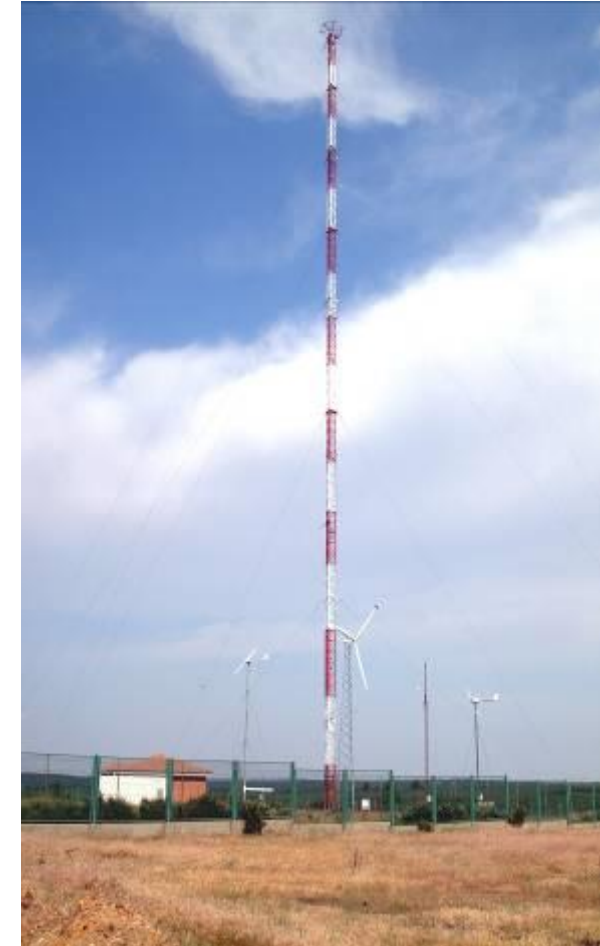
Predicción en tiempo real del viento en la torre de 100 m
