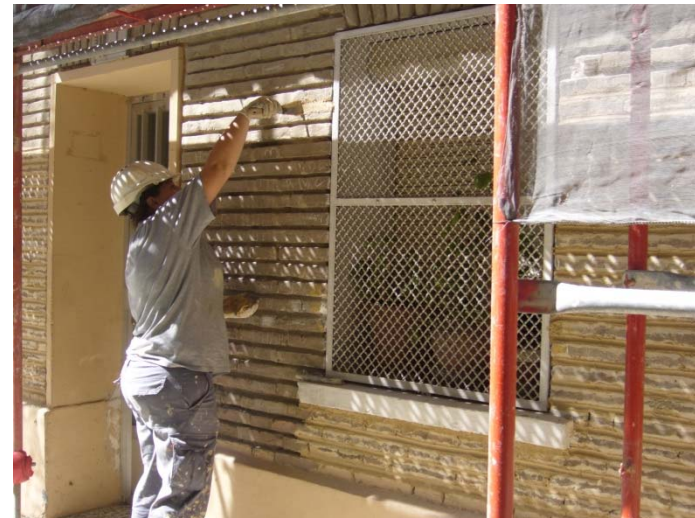
Reformas y rehabilitaciones
